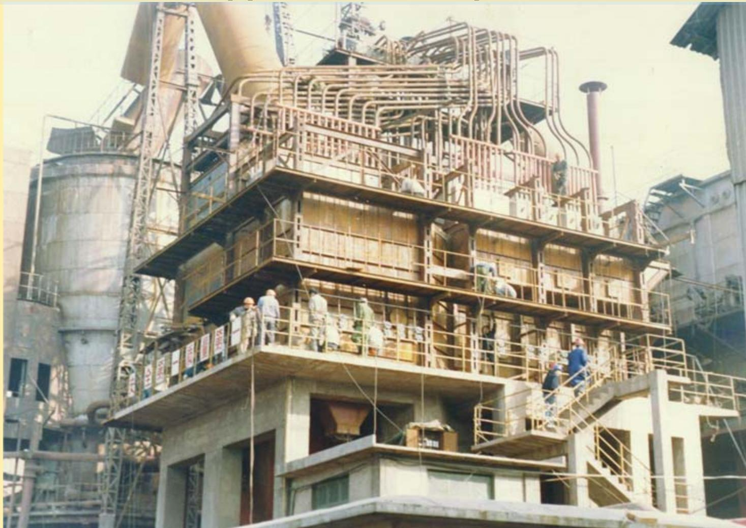
回收高温、高含尘、强腐蚀性气体热量，产生中、低压蒸汽
