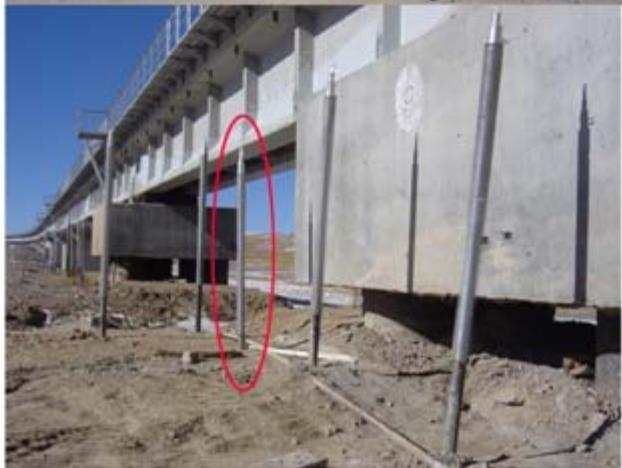
6号墩安装现场(下图为热棒安装未校正时照片)
