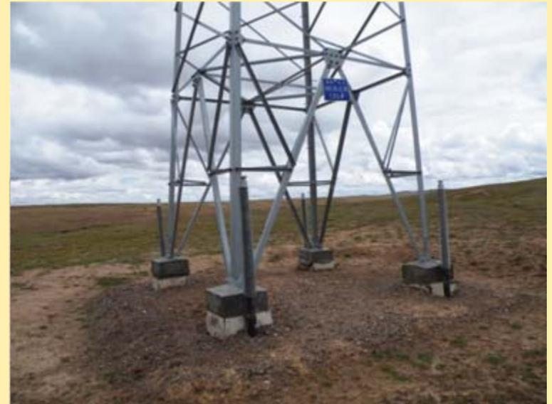
热棒在青藏高原输变电塔基础上的试验应用
