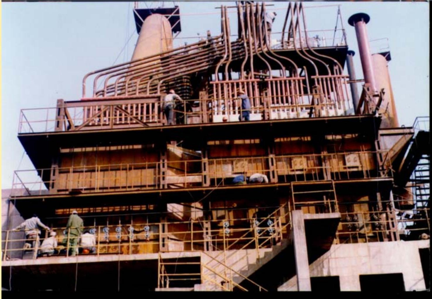
硫酸行业热量回收用大型热管蒸汽发生器施工现场
