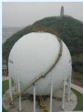
重庆燃气集团公司国内首台完全国产化、分析设计的一万立方米天然气球罐
