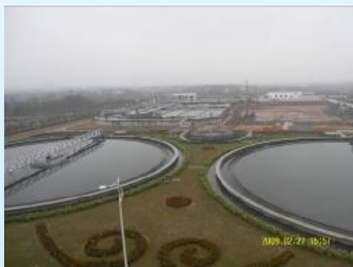
蔡田铺污水处理厂，日处理5万吨
