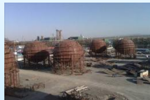
天津石化公司两千立方米球罐无损检测
