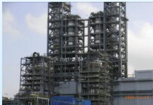
独山子加氢反应器无损检测
