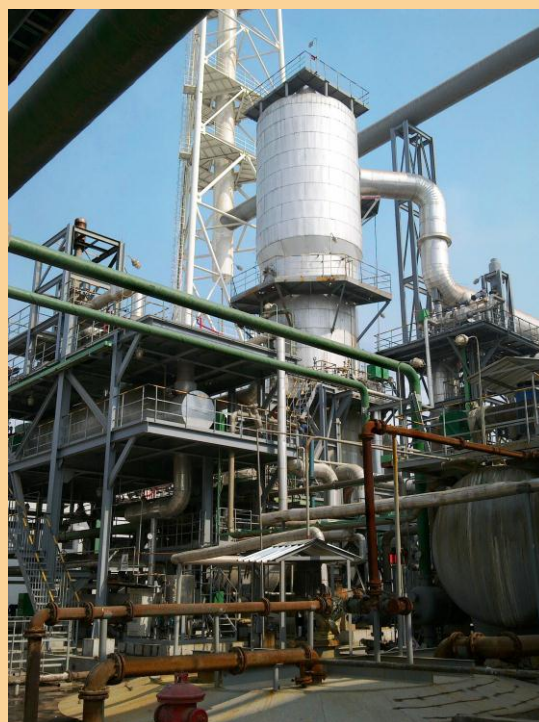
湖北三宁化工股份有限公司 35 万吨/年硫磺制酸 HRS 装置技改工程 0.3 million tons /year sulfuric acid With HRS Reconstruction project of Hubei Sanning Chemical Co.,Ltd
