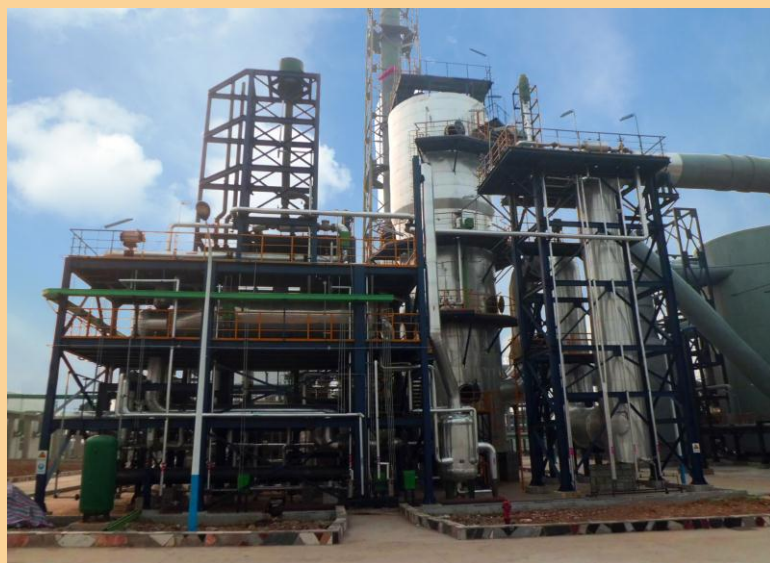
无锡格林艾普化工股份有限公司 60万吨/年硫磺制酸 0.6million tons /year sulfuric acid of Wuxi Greenapple Chemical Co.,Ltd
