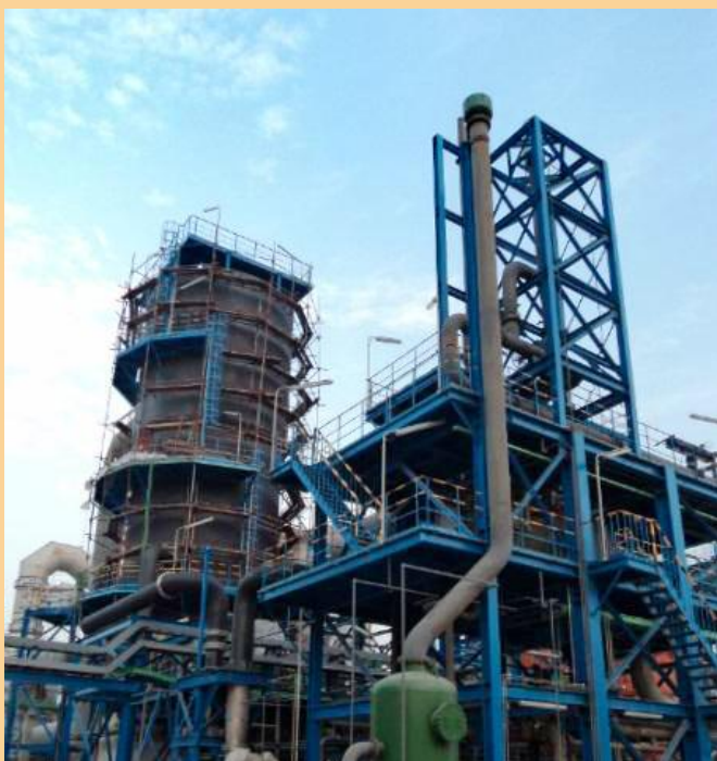
湖北大峪口化工有限公司 80 万吨/年硫酸装置 HRS 装置国内配套工程 0.8 Million tons /year Sulfuric Acid with HRS auxiliary projects of Hubei Dayukou Chemical Co.,Ltd
